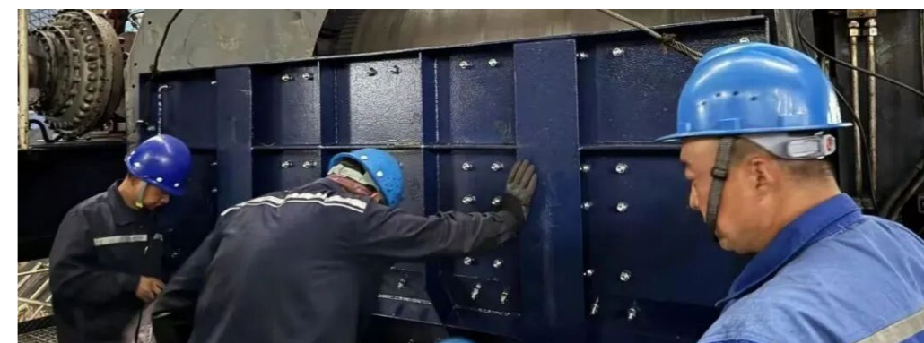
深国际港口 | 江苏靖江港斗轮机料斗改造
