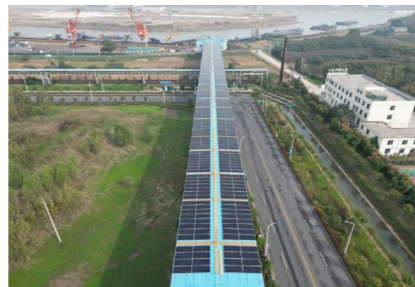
河南沈丘港光伏项目
