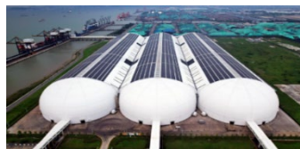
靖江港棚厂已覆盖光伏
