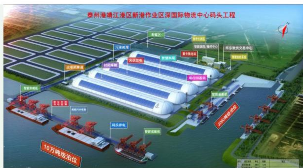
▲ 通过全封闭大棚+光伏发电组件的有机结合，控制堆场扬尘的同时，实现电力自发自用，既节能又环保。
