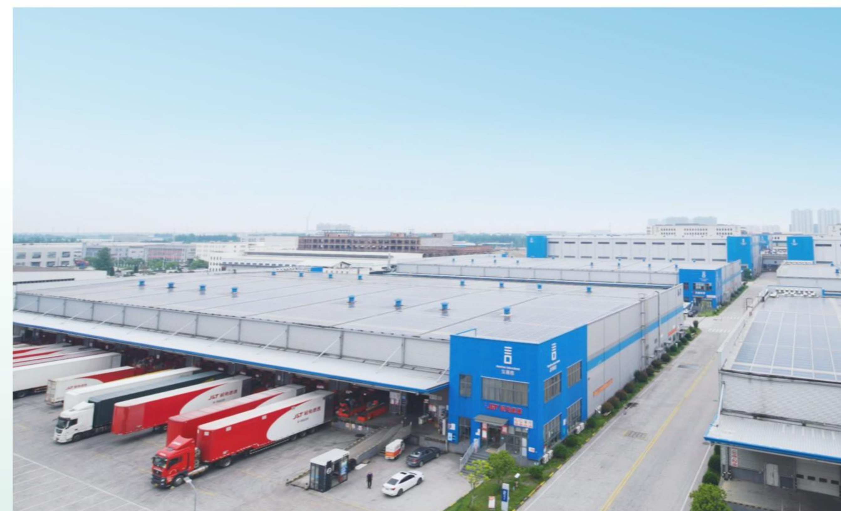
▼深国际杭州综合物流港屋顶光伏
