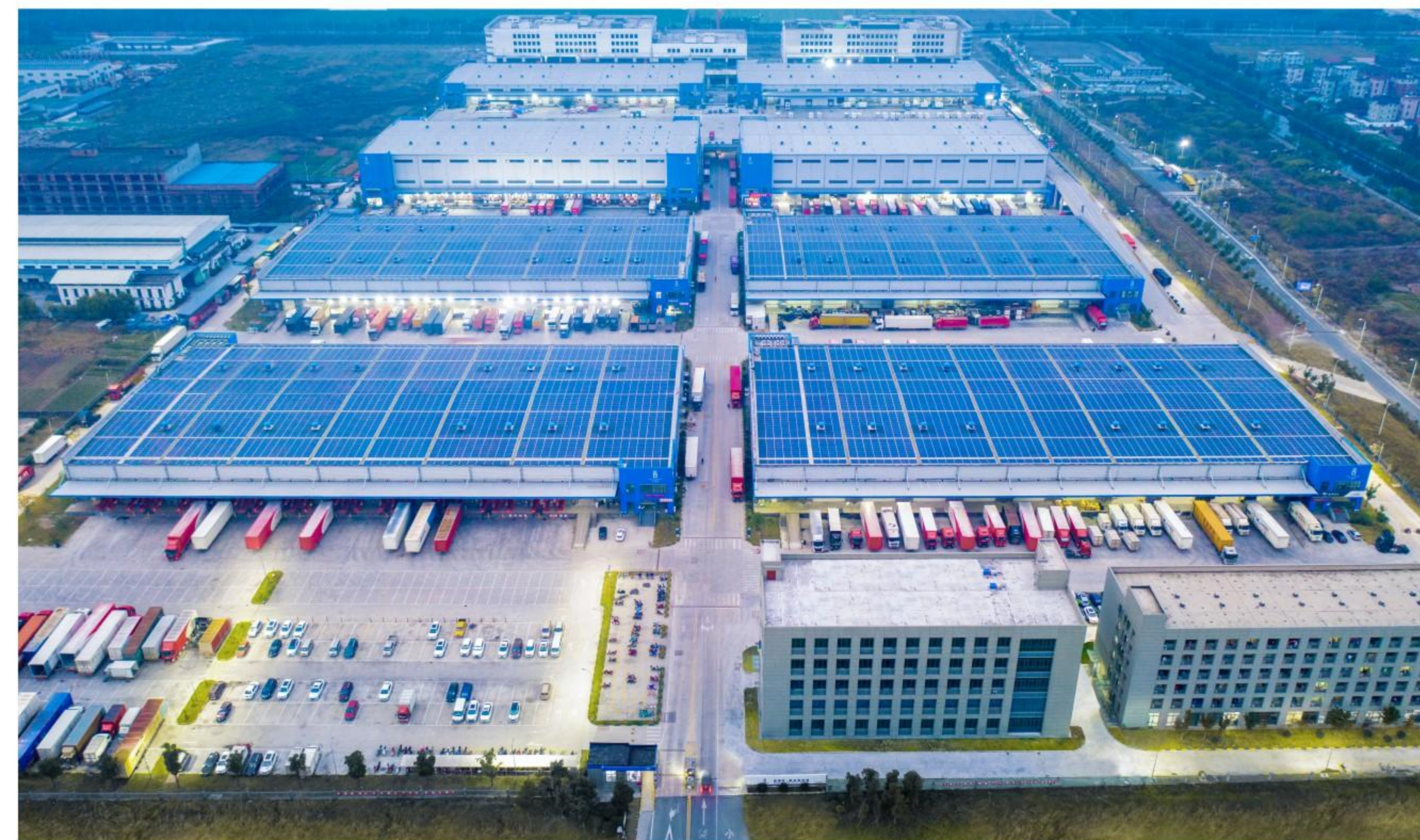
▲ 深国际杭州综合物流港屋顶光伏
